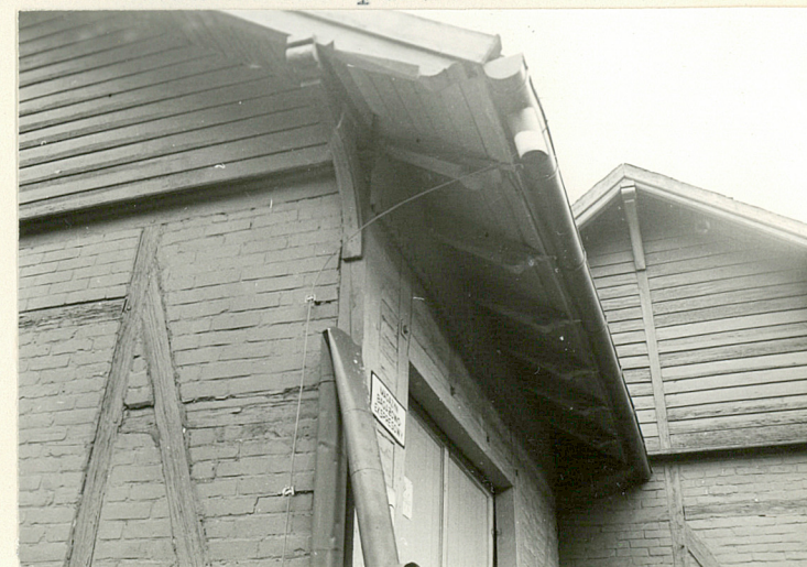
ryglowa konstrukcja płn-zach. narożnika
