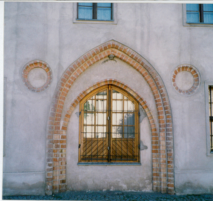
Blenda portalowa w elewacji wschodniej
