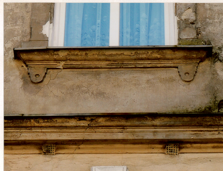
Gzyms podokienny III kondygnacji elewacji frontowej
