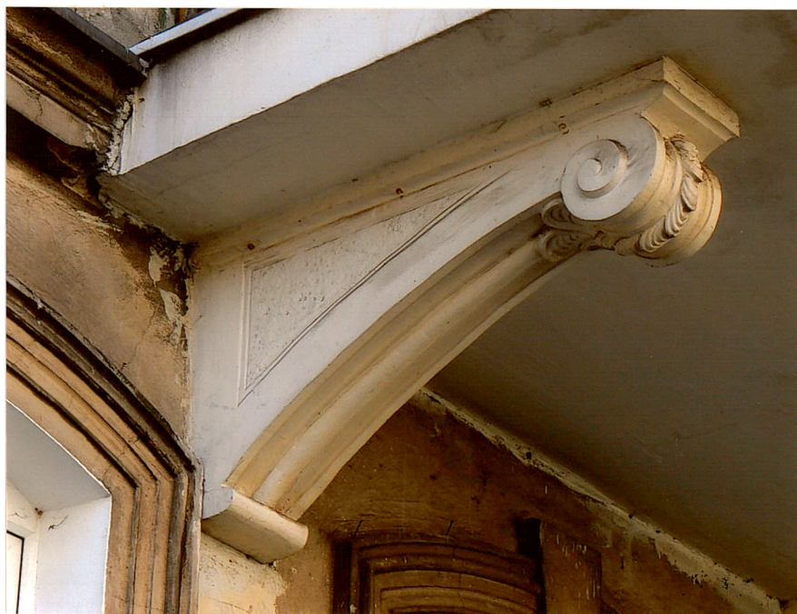
Wspornik balkonu elewacji frontowej
