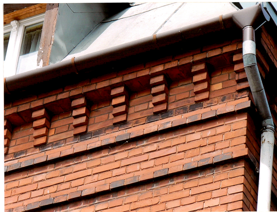
Fragment gzymsu wieńczącego elewacji tylnej
