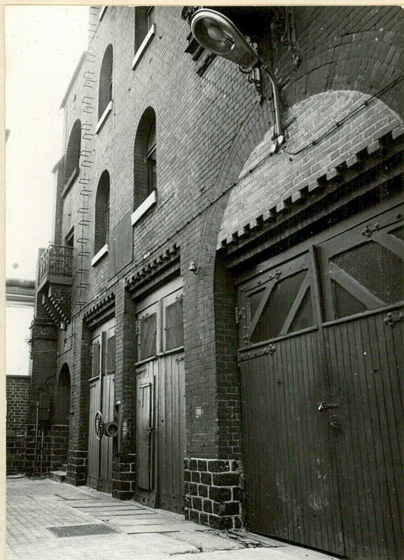
dolna partia wsch.elewacji wieży i widoczne zamurowanie wypełnienia łuku przejazdu
