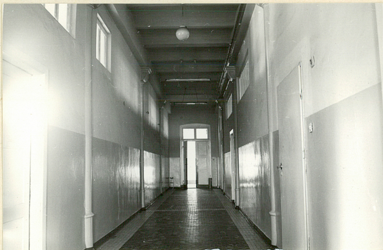
korytarz - widoczne kolumny wspierające odcinkowy strop
