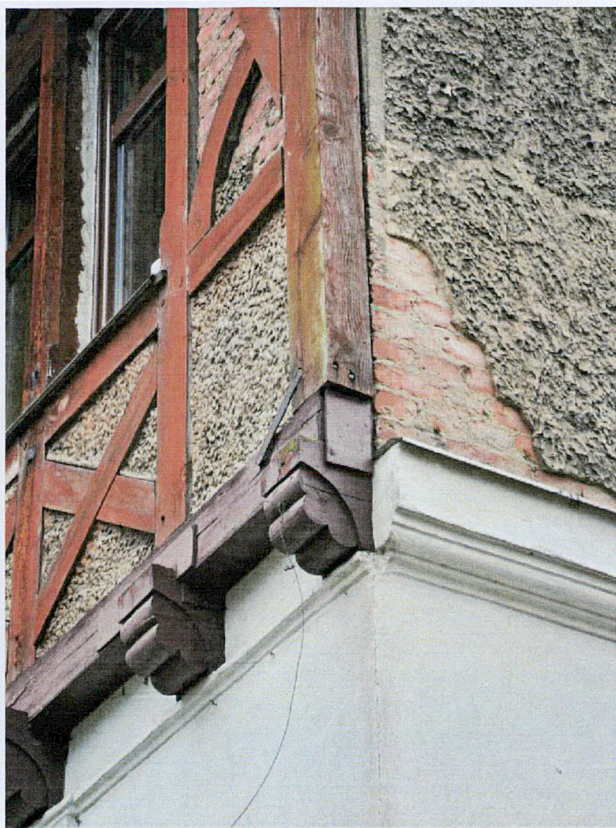
Fot.10 – konstrukcja ściany ryglowej w obrębie fasady
