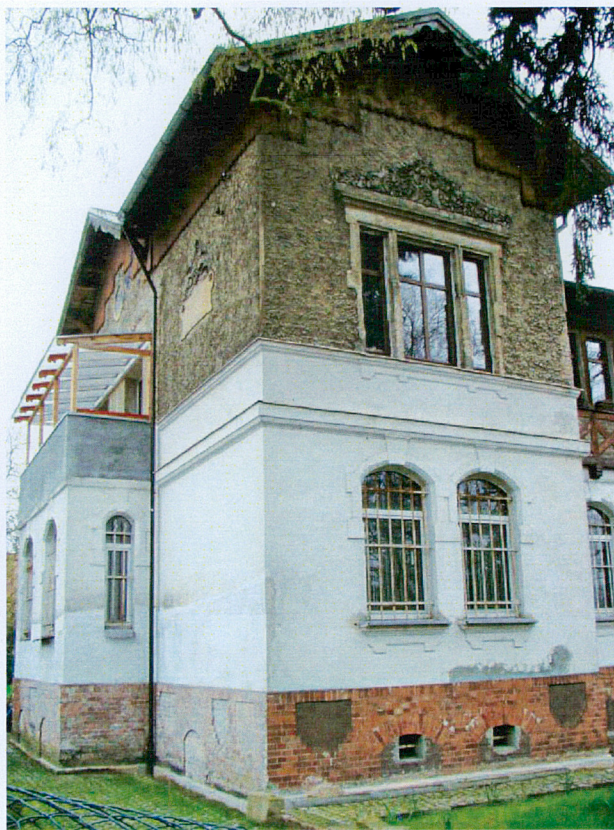
Fot.08 – elewacja frontowa, ryzalit ściana murowano-ryglowa
