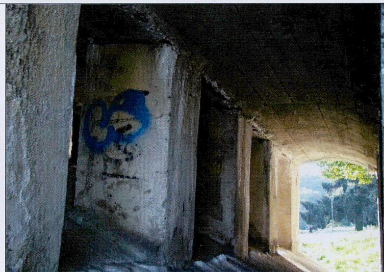
Fot.16. Słupy wewnętrzne między płytą sklepienia i płytą pomostu
