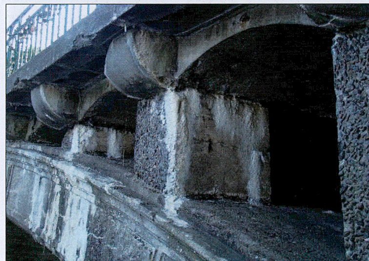
Fot.18. Słupy zewnętrzne między płytą sklepienia i płytą pomostu
