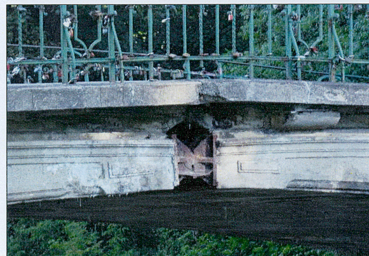
Fot.13. Przegub dolny, część południowa
