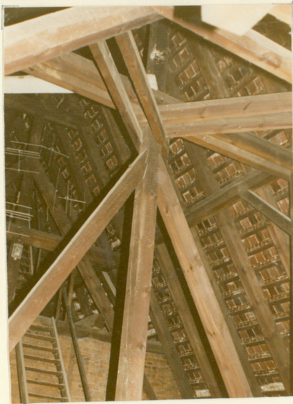
elementy więźby dachowej w części ryzalitu środkowego
