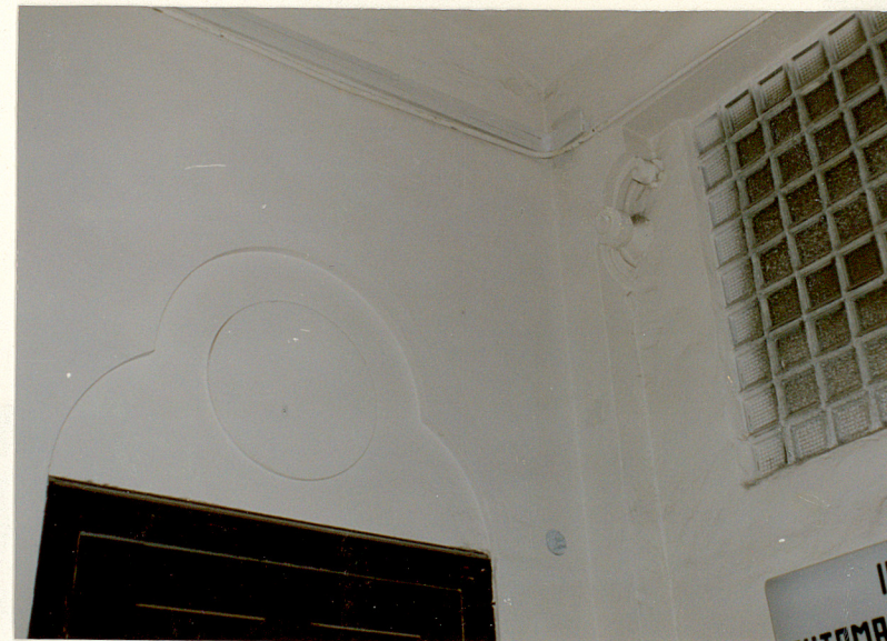
wtórna ściana działowa widoczny zniszczony detal i detal obramienia drzwi, od strony korytarza
