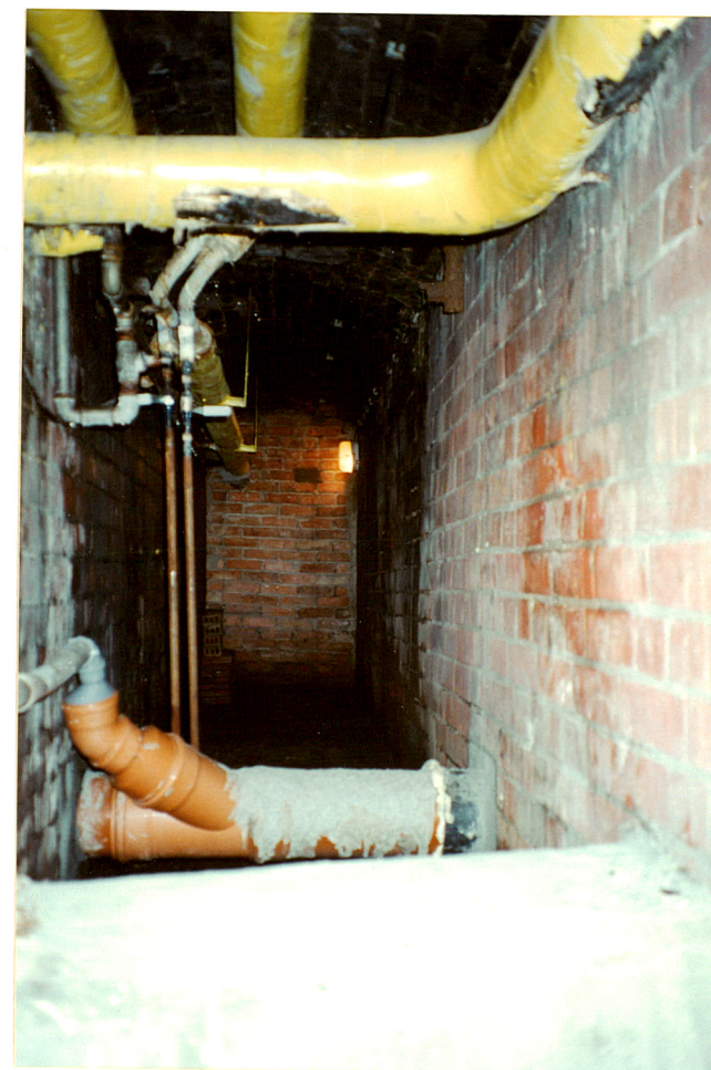
Kanał ciepłowniczy łączący dawną kotłownię z wnętrzem kościoła
