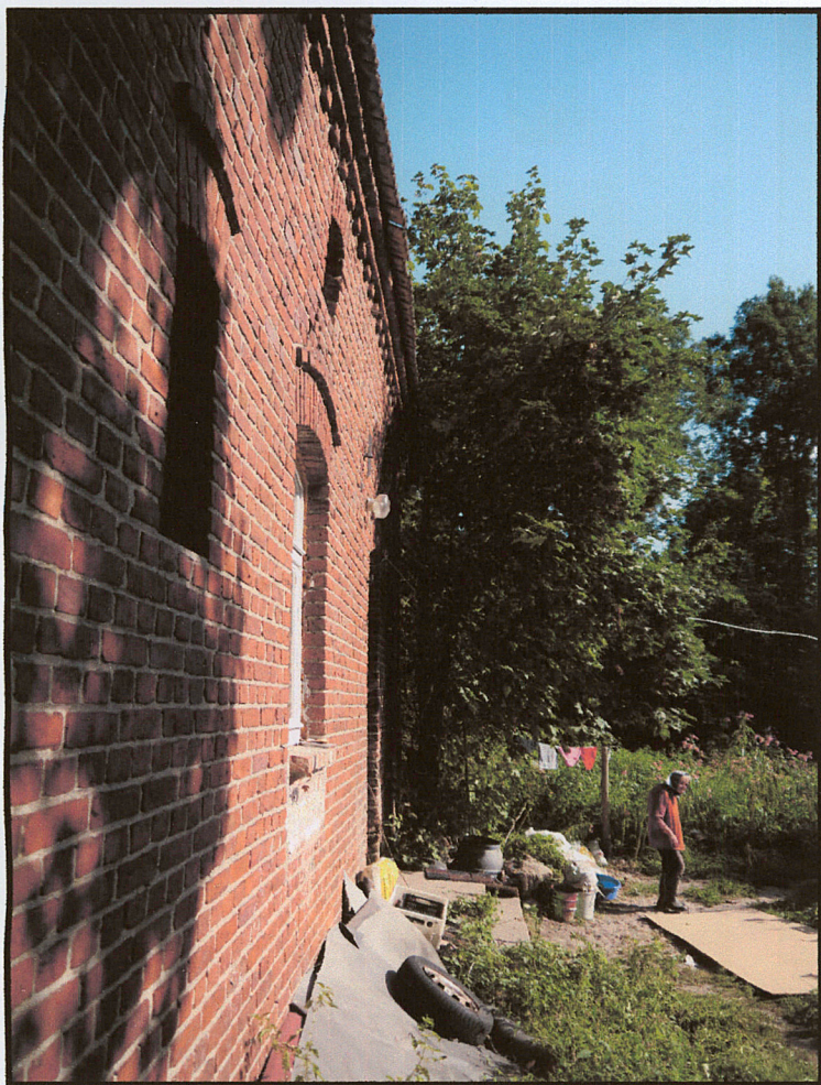
fot 7. Wyboczenie ściany tylnej (płd. - zach.)
