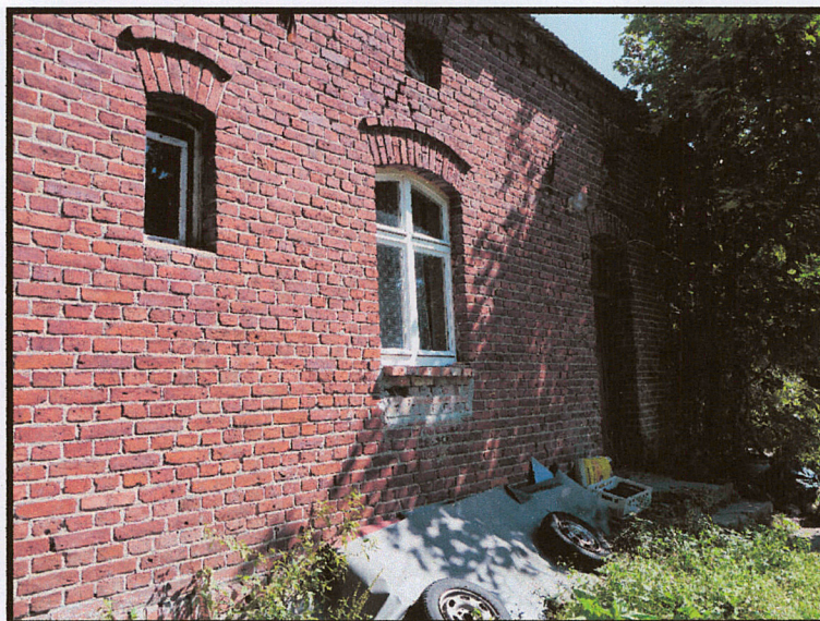
fot 8. Elewacja tylna (płd. - zach.), woboczenie ściany, spękania, detal okna
