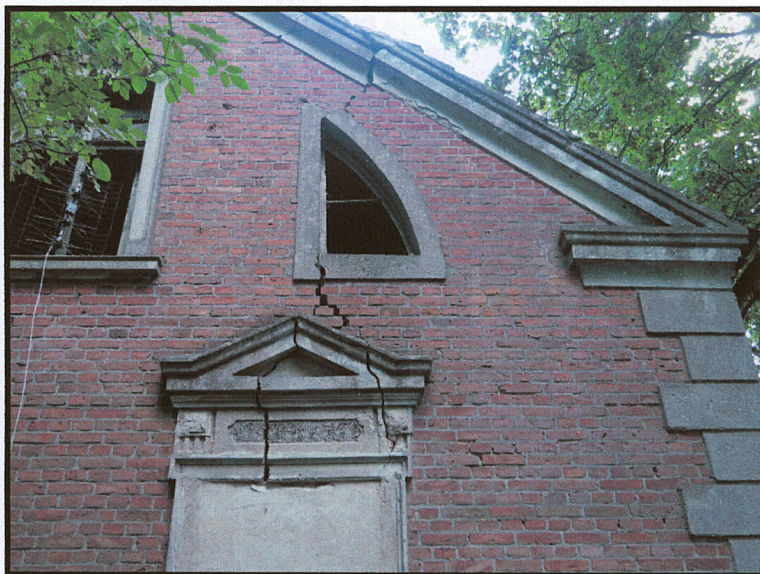
fot 3. Uszkodzenia na elewacji szczytowej (płn. - zach.)
