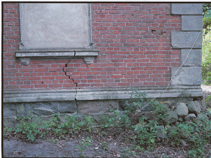
fot 4. Uszkodzenia na elewacji szczytowej (płn. - zach.)
