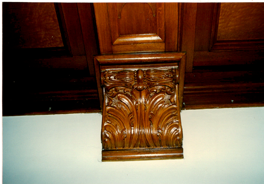
16. Konsola pod trzymająca belkę stropu w holu głównym.
