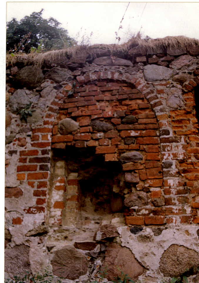
12. Zamurowany otwór w ścianie pld., widok z wnętrza nawy.
