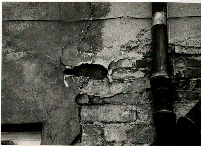
1.fragm.elewacji tylnej pld. - widoczne różne formy cegieł
