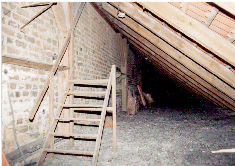
21. Więźba dachowa nad nawą boczną.
