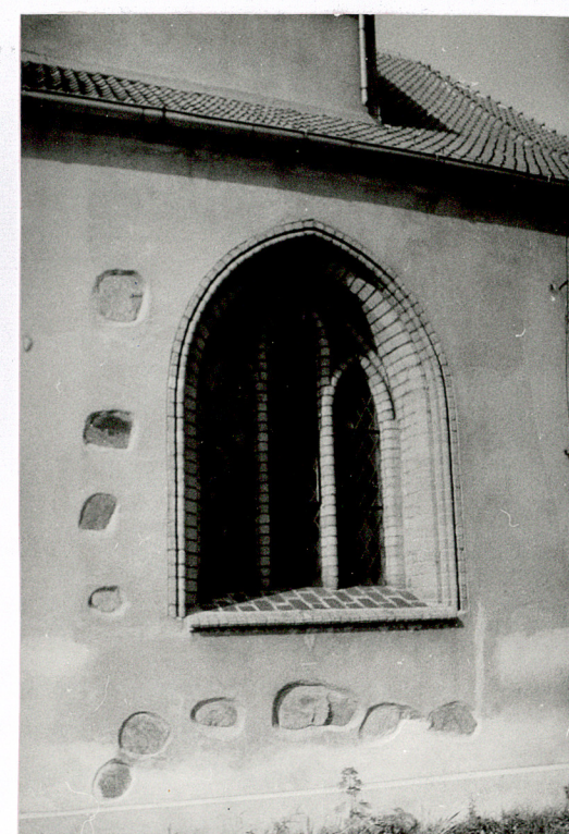
14. Okno pld.; odkryta kamie na struktura muru.
