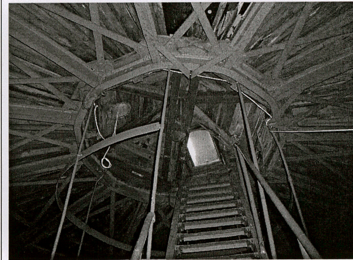
Konstrukcja dachu głowicy i pierścień konstrukcyjny podstawy świetlika (lunety)
