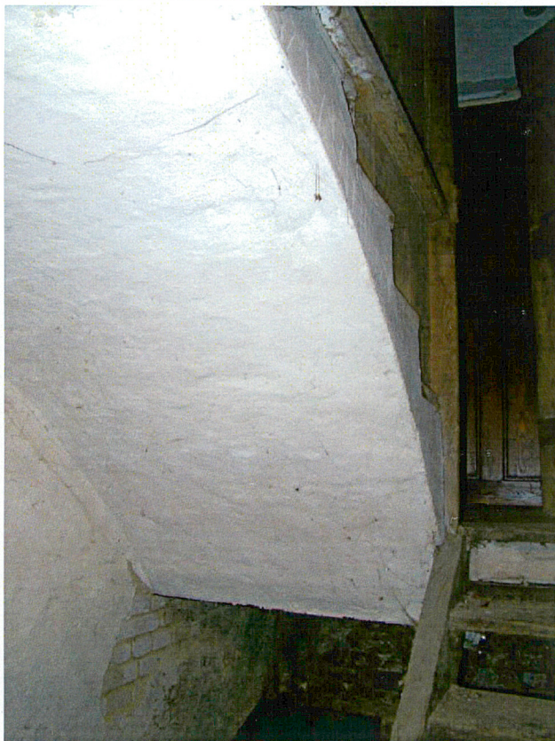
Fot. 28 – oficyna wschodnia, ceglane biegi schodowe
