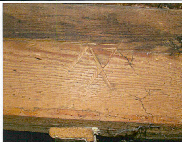
Fot. 21 - kamenica, więźba dachowa – znak montażowy
