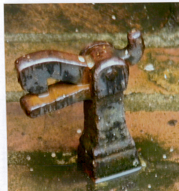
Element do blokowania drzw przy wejściu głównym
