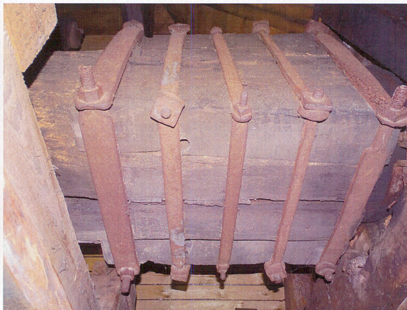
Fot. 20 – obejmy żelazne wzmacniające zakończenie wału skrzydłowego
