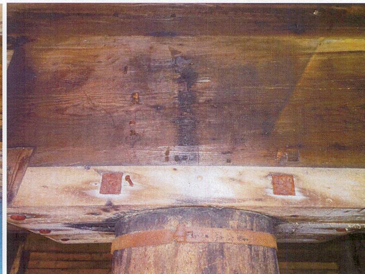
Fot. 15 – osadzenie sztembra w poduszce mącznicy
