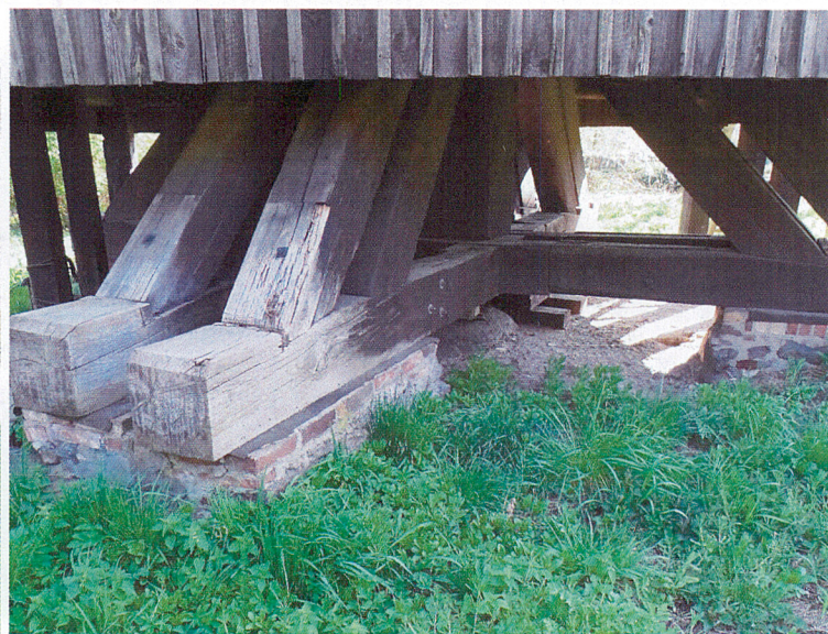
Fot. 9 – podwaliny wiatraka wraz z fragmentem zastrzałów
