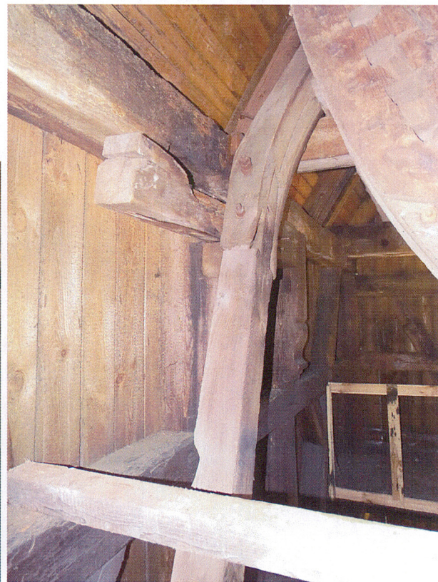
Fot. 18 – kondygnacja III – fragment zachowanego hamulca
