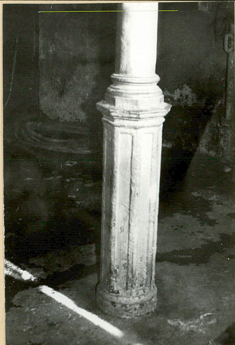
Kolumna podpierająca strop w aparatowni
