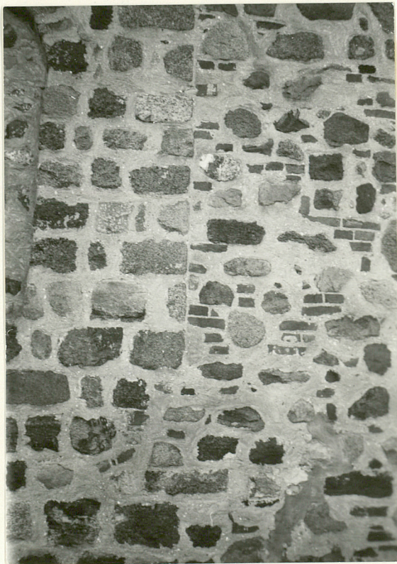
elewacja pñ. - widoczne łaczenie muru nawy i wieży
