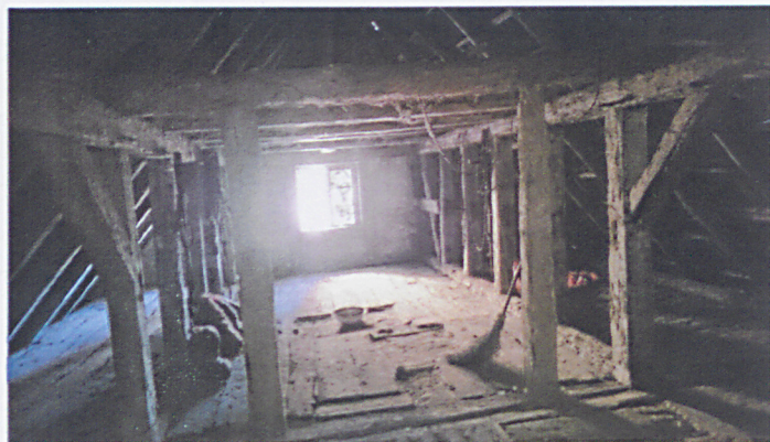
Więźba dachowa nad budynkiem głównym.
