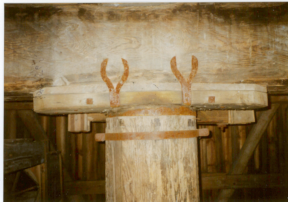
15. Detal połączenia mącznicy ze słupem, neg. 400/56/2.
