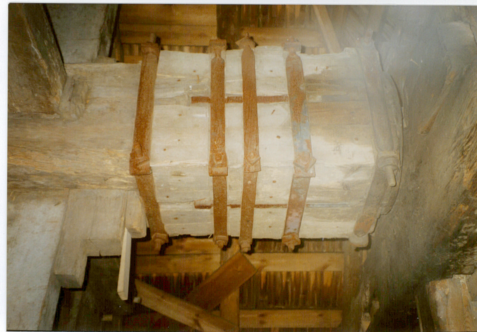
8. Zamocowanie głowicy w wale skrzydłowym, neg. 400/56/4.
