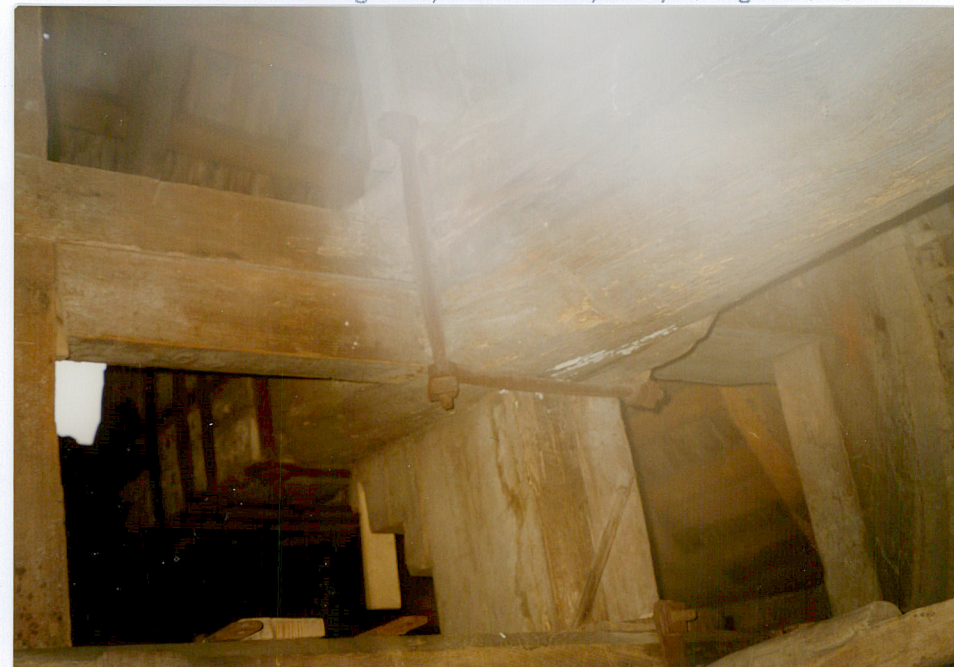
10. Zamocowanie koła palecznego w wale skrzydłowym, neg. 400/57/2
