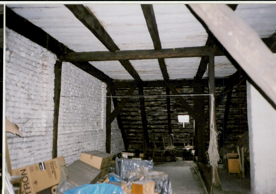
25. Poddasze strychowe - dolna kondygnacja: trójrzędowa rama stolcowa - widok w kierun- ku połaci wschodniej; więzar pełny z pe belką więzarową.
