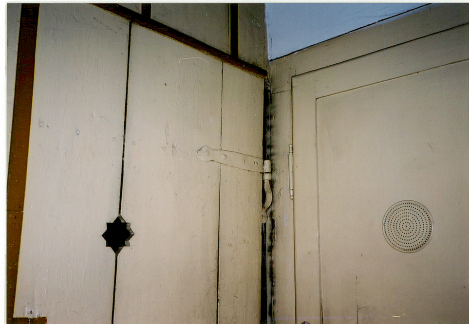
14. Fragment drzwi z sieni do piwnicy na zawiasie poziomym i drzwi do szafki ściennej na zawiasie francuskim.
