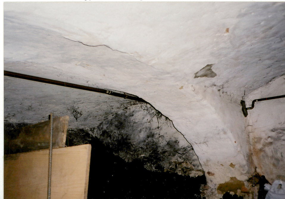
11. Fragment wnętrza piwnicy - dwa przęsła sklepień rozdzielone ścianą, w której szeroka arkada.
