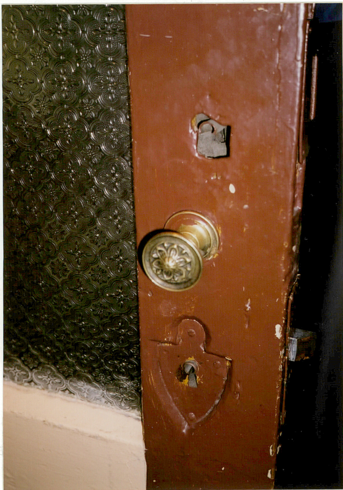
20. Gałka i szyldzik drzwi oddzielających bieg schodów od korytarza na piętrze.
