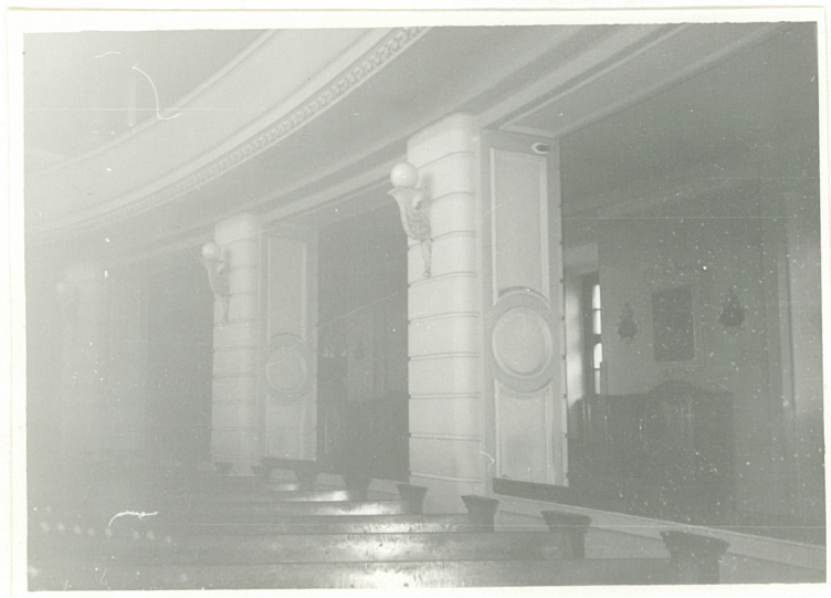
14. Kolumny dźwigające balkon II kondygnacji
