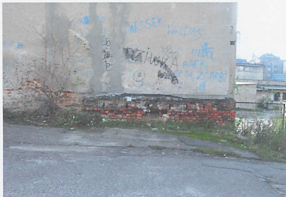
Widoczna u podstawy północnej elewacji pozostałość muru sąsiedniej budowli
