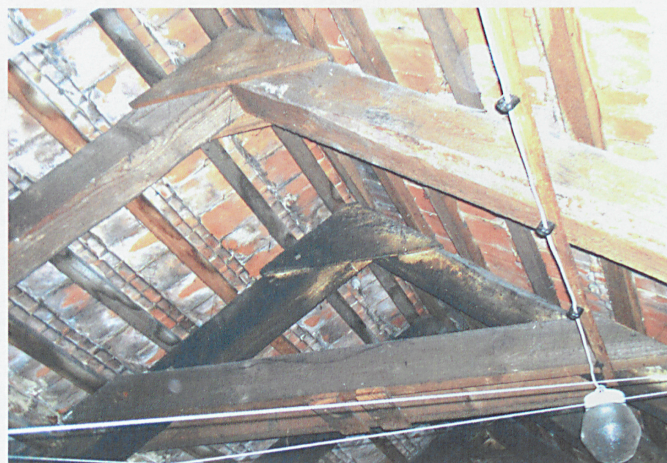
Górna część wiażara z kleszczowym usztywnieniem
