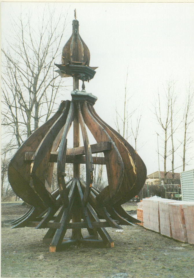
KONSTRUKCJA WIEŻY PO ZDJĘ- CIU PORUCYCIA
