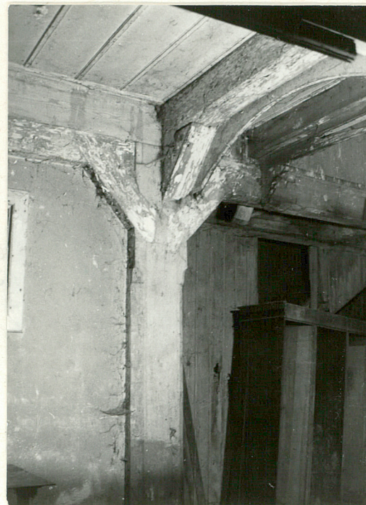
30. Słup podtrzymujący balkon
