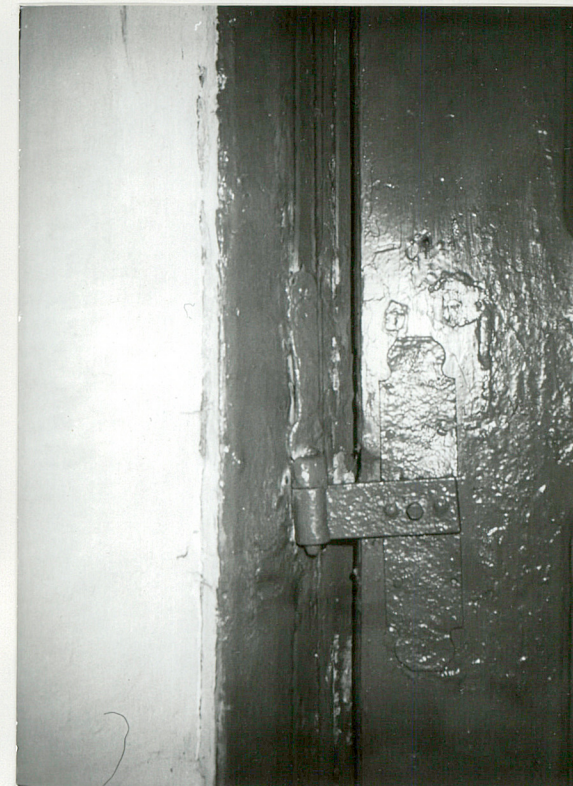
zawias pasowy w drzwiach z sieni do pokoju w części wsch od pn
