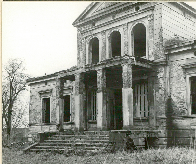
Fot. 16. Fragment elewacji południowej - środkowy razalit poprzedzony jest parterowym gankiem wspartym na czterech cienkich, kanelowanych filarach, nakryty od góry balkonem.
