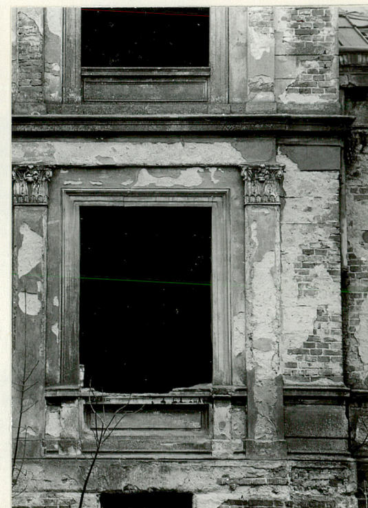
Fot. 22. Elewacja północna - opracowanie otworów okiennych w kondygnacji parteru i profile gzymsów: cokołowego, podokiennego i kordonowego.
