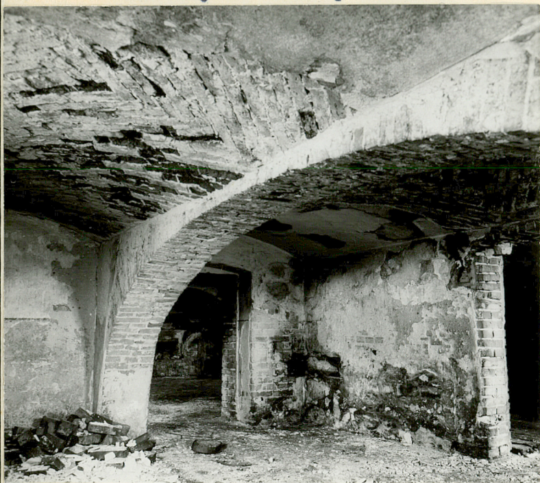
Fot. 8. Wnętrze piwnicy pod pomieszczeniem nr 8, przesklepienie dwoma przęsłami sklepień odcińkowych; drzwi z lewej prowadziły do dawnej kuchni.
