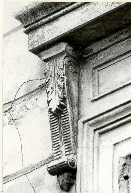
Fot. 26. Konsola podtrzymująca nadokiennik w kształcie fragmentu gzymsu.
