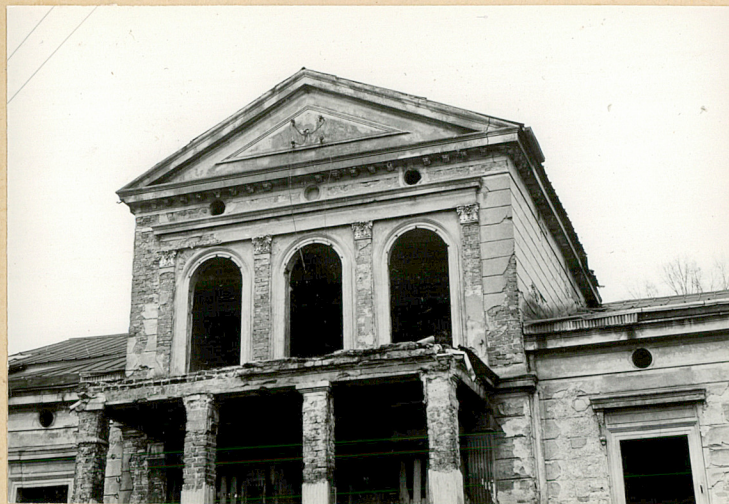
Fot. 10. Fragment elewacji południowej. Przypuszczać należy, że wykonując przyłącze elektryczności zniszczono dekorację tympanonu /prawdopodobnie herb/ - skoro istnieje dekoracja heraldyczna w elewacji tylnej.
