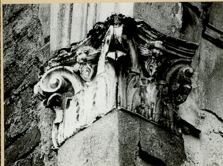
Fot. 14. Głowica pilastra nałożonego na węgar okienny w ryzalicie wschodnim.
