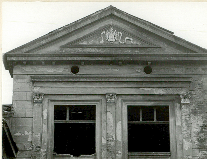
Fot. 20. Trójkątny naczółek wieńczący środkowy ryzalit w elewacji północnej.
