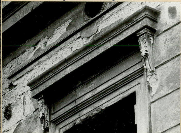
Fot. 15. Nadokiennik w kształcie fragmentu gzymsu podparty przez dwie pionowe konsole - typowe zwieńczenie otworu okiennego w skrajnych /narożnych/ częściach budynku.
