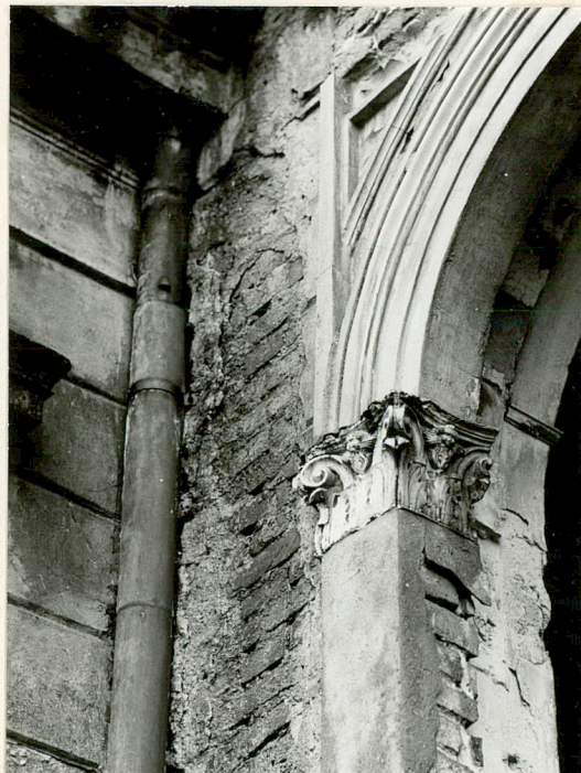
Fot. 25. Opilastrowany węgarek i profil archiwolty otworu okiennego w ryzalicie wschodnim.
