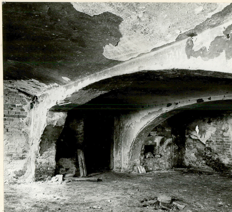
Fot. 3. Wnętrze największej przestrzeni piwnicy pod pomieszczeniem parteru nr 5 - prawdopodobnie kuchnia. Przy narożniku widoczny jest otwór do pieca chlebowego.
