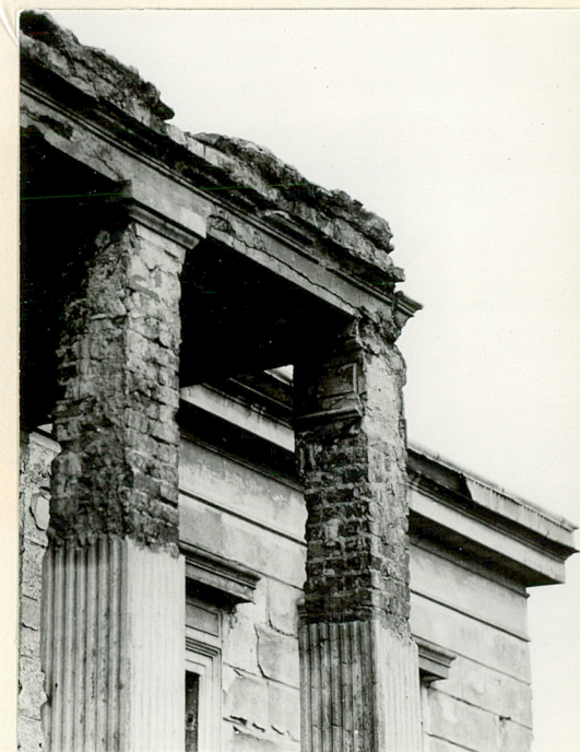
Fot. 18. Skorodowany gzyms ganku przy elewacji południowej i widok profilu gzymsu koronującego parterowe - skryjne części budynku.
