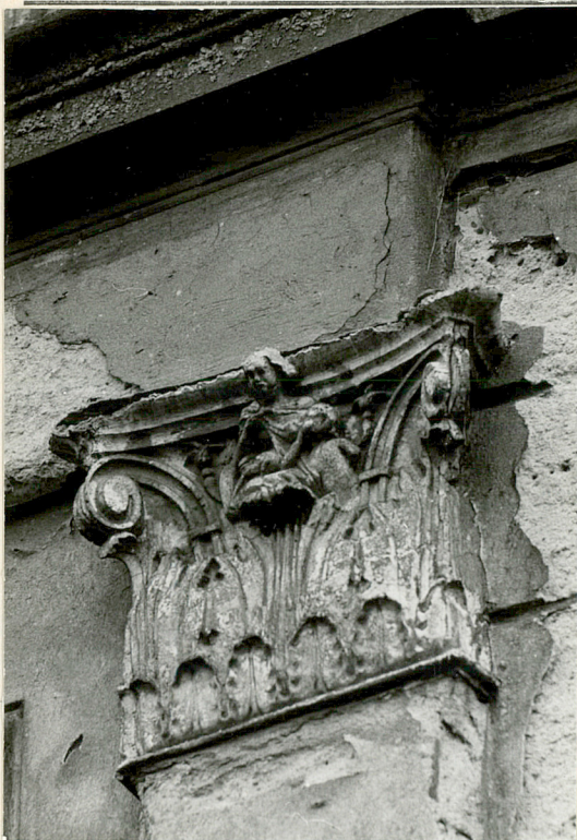
Fot. 24. Głowica pilastra członującego ryzalit północny w kondygnacji parteru..
