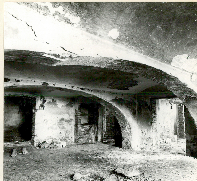
Fot. 4. Wnętrze piwnicy pod pomieszczeniem nr 5 - przesklepione jest trzema przesłami równoległymi do siebie sklepien odcinkowych które oparte są na ścianach w których wycięte są duże, szerokie arkady założone na łuku kośzowym. W narożniku widoczna jest szafka ścienna.
