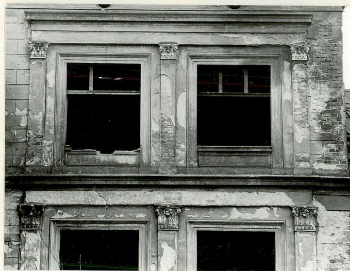
Fot. 21. Elewacja północna - resztki stolarki okiennej na piętrze w ryzalicie środkowym; architektoniczne opracowanie otworów okiennych.
