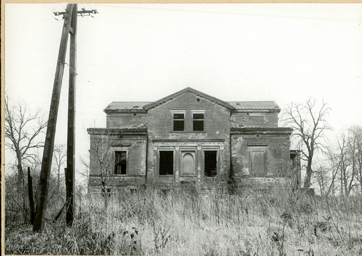
Fot. 11. Elewacja zachodnia. Pięcioosiowa, z trój- osiowym piętrowym ry- zalitem w części środ- kowej.
