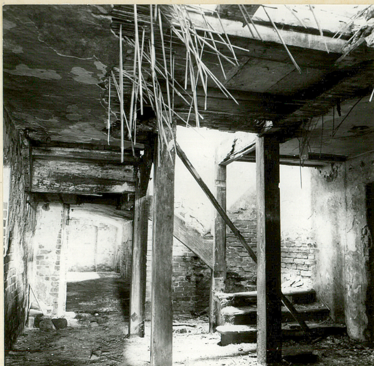
Fot. 6. Wnętrze piwnicy pod pomieszczeniem nr 1a - resztki schodów prowadzących z piwnicy do westybulu.
