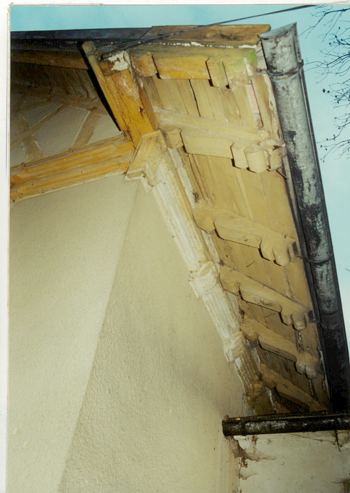
6 Ciesielsko powycinane końcówki krokwi pod okapem przy północnym narożniku budynku.
