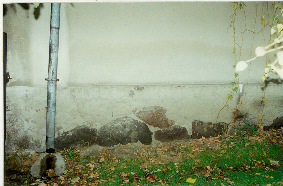
15 Fragment cokołu w elewacji południowo-wschodniej - z dużych kamieni łamanych.
