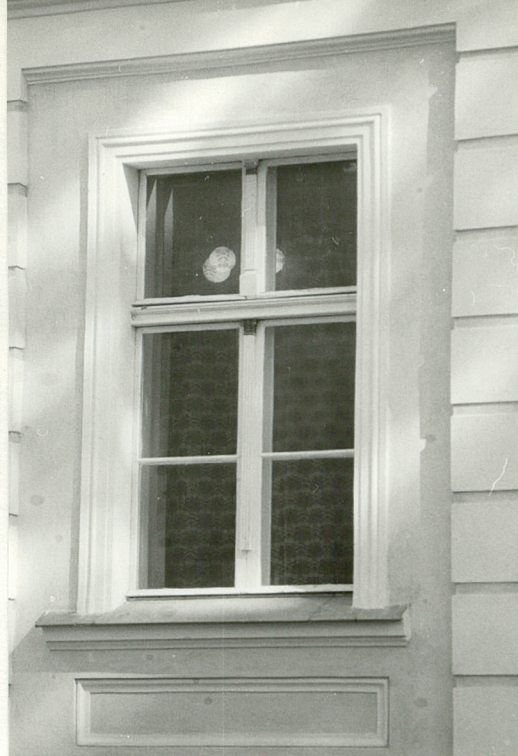
Fot.16. Typowe okno z listwą przyrymową w kształcie pilastra z cynowym kapytelem.
