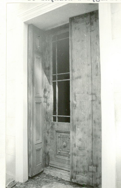
Fot.8. Główne drzwi wejściowe skrzydła zewnętrzne we wnękach w węgarze.
