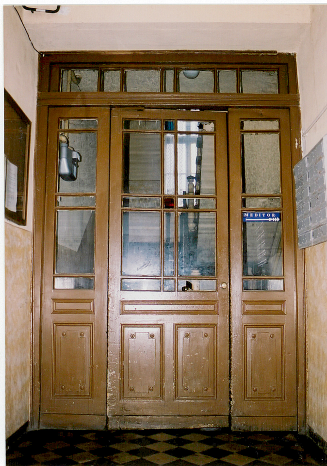
Stolarka drzwi pomiędzy sienią a klatką schodową (1), stolarka klatki schodowej (2), posadzka z płytek ceramicznych w sieni (3).
