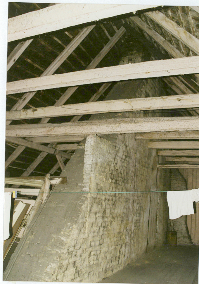
21. Fragment więźby dachowej ze ścianą konstrukcyjną kominową
