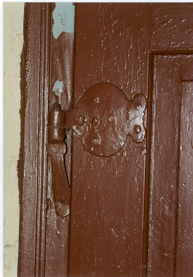
14. Zawias tarczowy w drzwiach do skrytki
