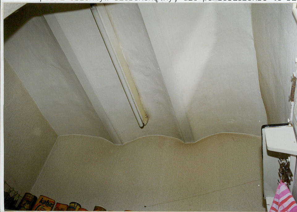
12. Wnętrze ciemnego pomieszczenia kuchni /11/ na parterze → widok na strop zasklepiony kapą pruską; zbiegające się ku górze ściany to nie jest zniekształcenie fotografii przez obiektyw szerokokątny, ale pomieszczenie to rzeczywiście
