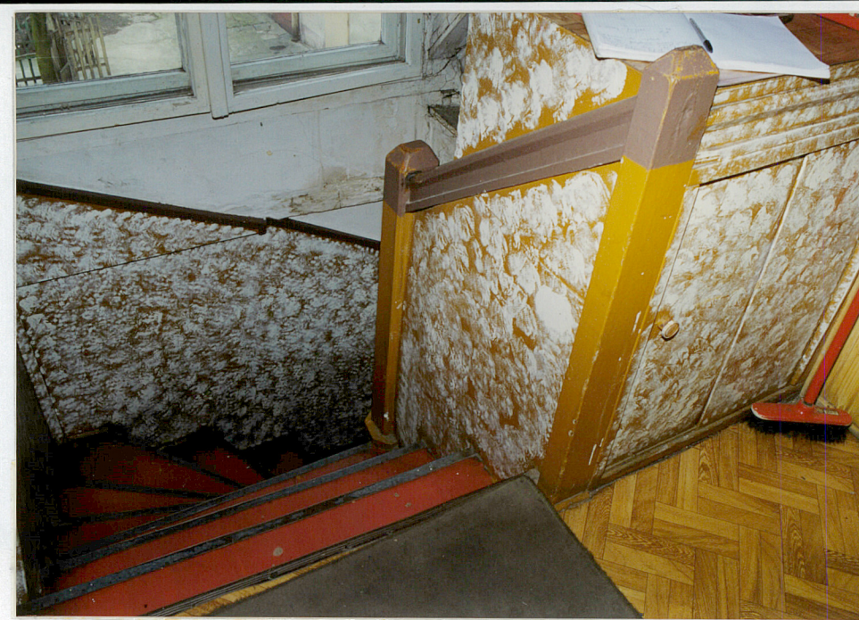
14. Słupki balustrady i fragment schodów zabiegowych (jednobiegowych, powrotnych → widok z użytkowego poddasza.
