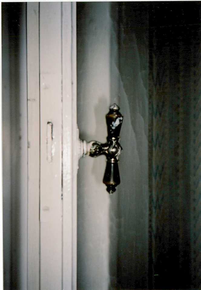
18. Klamka okna – symetryczna ornamentowana z metalowa z elementami drewnianymi.
