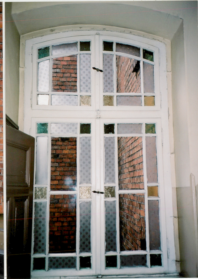
37. Okno klatki schodowej w części domu od ul. Marcinkowskiego 11 widoczne od strony klatki schodowej oszklenie z szyb białych, białych piaskowanych i kolorowych, oryginalne pojedyncze, krosnowe, z oryginalnymi okuciami.
