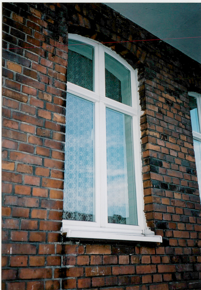
28. Nowe okno w elewacji od ul. Marcinkowskiego. drewniane. pojedyncze typu euro czterokwaterowe, dwuskrzydłowe, z profilowanym ślemieniem łączonym z obu skrzydeł.
