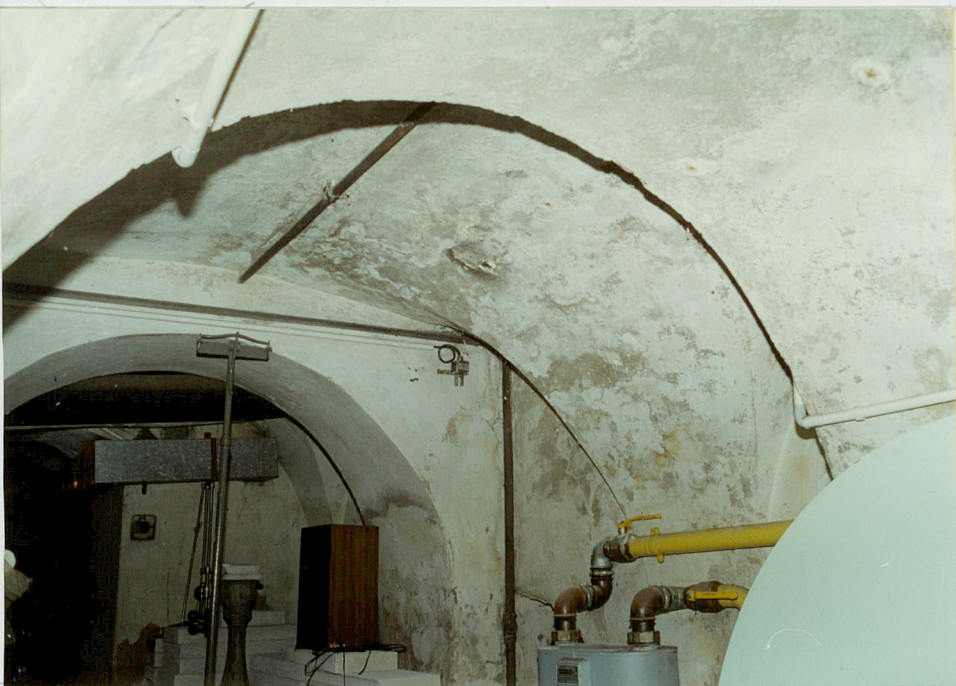
28 Piwnica pod pomieszczeniem /7/ → widok na sklepienie kolebkowo-krzyżowe (dwa przęsła) dodatkowo podparte w każdym przęśle ścianą, w której wycięta jest arkada. 29 → widok na ścianę północną i zachodni narożnik. Nowy strop w pomieszczeniu piwnicznym zachodnim - na przedłużeniu piwnicy pod pomieszczeniem /6/ ku zachodowi.
