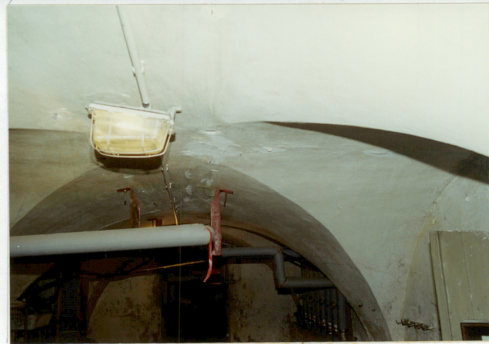
26 Piwnica pod pomieszczeniem /6/ → widok na sklepienie kolebkowo-krzyżowe → styk dwóch lunet → widok od strony wschodniej w kierunku zachodnim. 27 Piwnica pod pomieszczeniem /6/ → w wschodnim przęśle w północnej ścianie duża, szeroka, zasklepiona odcinkowo blenda wykorzystana jako szafka ścienna zamykana drewnianymi drzwiczkami.
