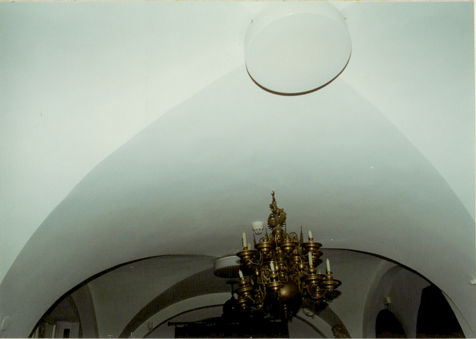
14 Fragment sklepienia kolebkowo-krzyżowego → styk dziobów lunet zasłonięty przez oprawy lamp.
