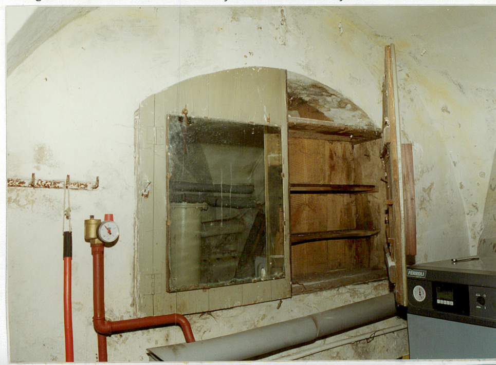
26 Piwnica pod pomieszczeniem /6/ → widok na sklepienie kolebkowo-krzyżowe → styk dwóch lunet → widok od strony wschodniej w kierunku zachodnim. 27 Piwnica pod pomieszczeniem /6/ → w wschodnim przęśle w północnej ścianie duża, szeroka, zasklepiona odcinkowo blenda wykorzystana jako szafka ścienna zamykana drewnianymi drzwiczkami.
