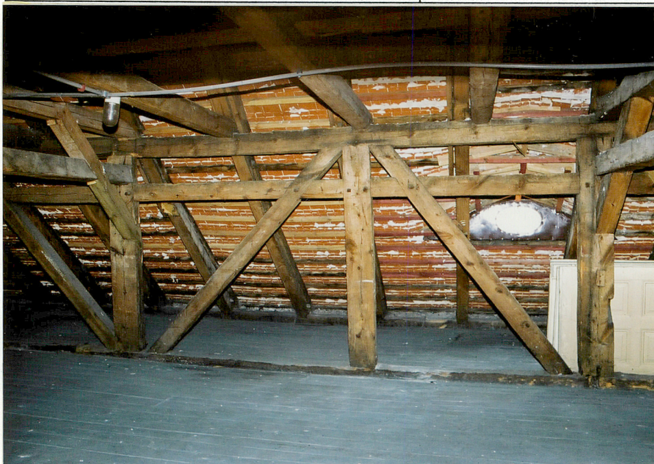
40. Fragment konstrukcji więźby dachowej - stolcowej, widok w poprzek budynku na dwa przęsła więźby, usztywnione podłużnie wysokimi, ukośnymi zastrzałami.
