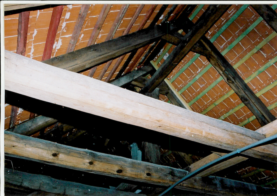
42. Poddasze strychowe → widok na górną część więźby dachowej - konstrukcja stolcowa z dwoma poziomami jętek.
