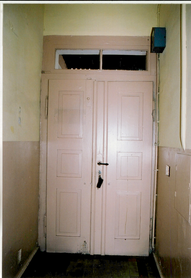
12. Główne drzwi wejściowe - widok od strony wnętrza sieni /1/ → skrzydła pozornie symetryczne na zawiasach francuskich z toczonymi końcówkami.
