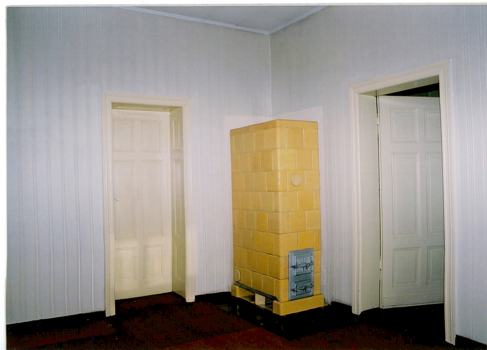
39. Piętro - wnętrze w trakcie południowym → widok na narożnik i drzwi, jedne ościeżnicowe, zwykłe, a drugie ze szpaletami (do traktu północnego).
