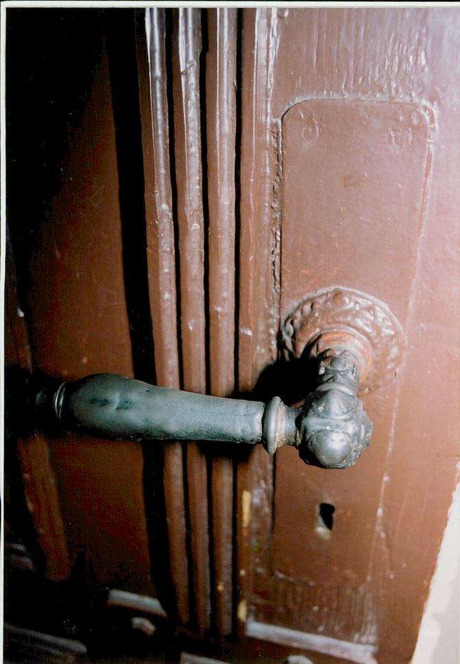
11. Fragment głównych drzwi wejściowych od zachodu do przybudówki pn.-zach. → żeliwna klamka i tarczka.
