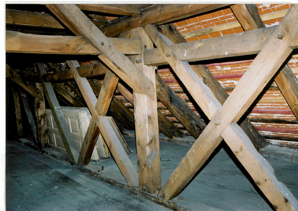
45. Fragment konstrukcji więźby dachowej - usztywnienie podłużne w kształcie krzyży św. Andrzeja i usztywnienia poprzeczne
