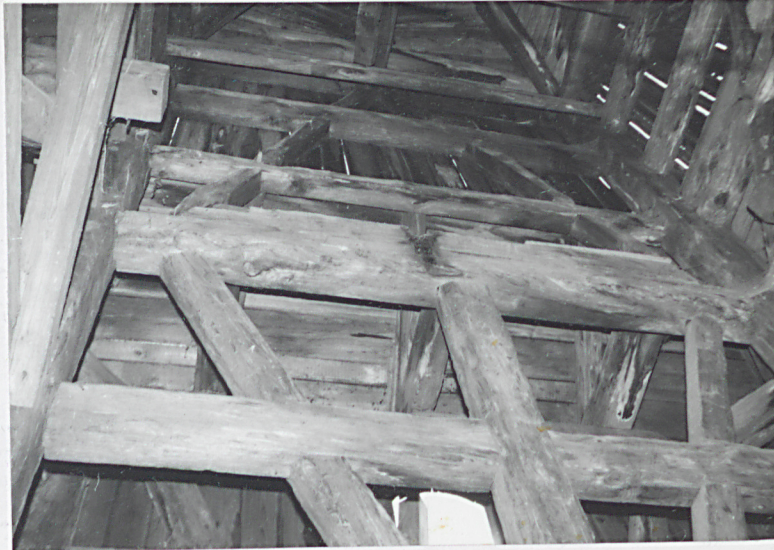
17 Fragment konstrukcji wewnętrznej ściany pd.-zach.: środkowy słup, dwa poziomy rygli i dwa ukośne zastrzały.
