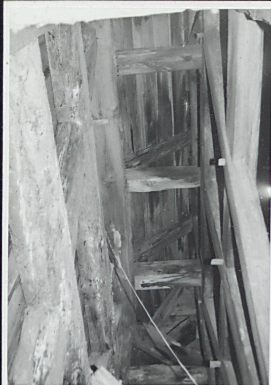
9 Wnętrze dzwonnicy - konstrukcja dolnej kondygnacji: ściana wewnętrzna (z prawej) oddalona jest od ściany zewnętrznej (z lewej) o ok. 80 cm - widok z narożnika południowego w stronę narożnika zachodniego - część dolna i w części górnej widać krótkie krokiewie dachu dolnej kondygnacji.
