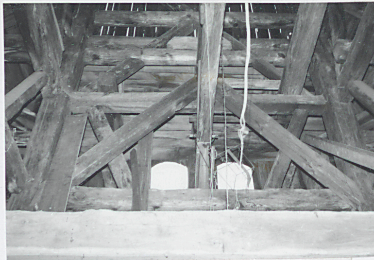
8 Wnętrze dzwonnicy - dwa zastrzały podtrzymujące belkę - widok na pn.-zach. ścianę.
