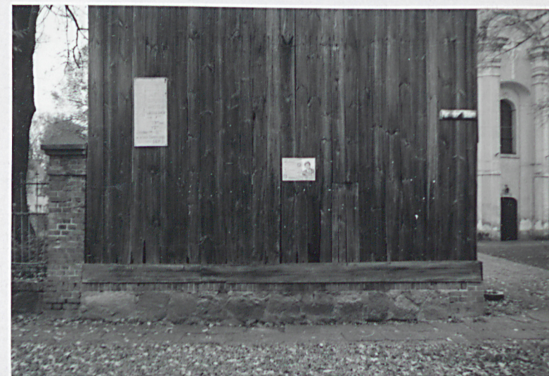
4 Fragment elewacji głównej pn.-zach. murowany cokół i dolna część drewnianych ścian dolnej kondygnacji.
