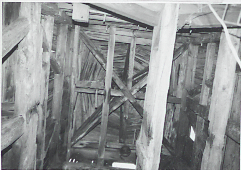
14 Konstrukcja kopulastego dachu dzwonnicy i mały dzwon przy otworze w pn.-zach. ścianie.
