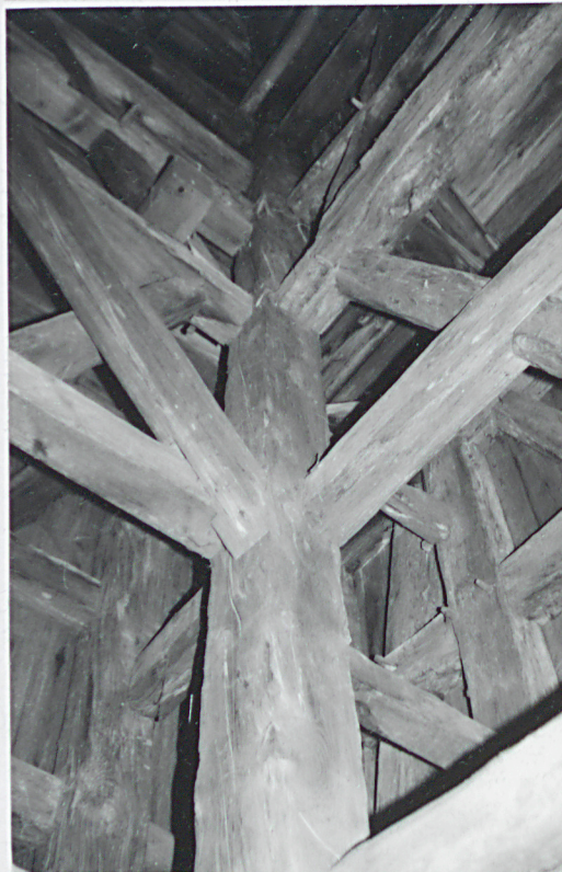
16 Narożny słup wewnętrznej ściany wieży biegnie przez całą jej wysokość i jest w nim zaczopowanych 7 poziomów rygli.
