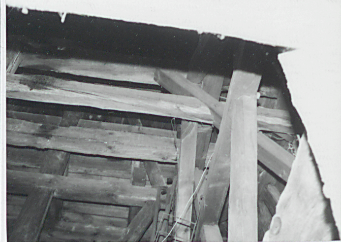
6 Wnętrze dzwonnicy - ten sam element wieszarowy nad drzwiami wejściowymi (widok z pd. narożnika).
