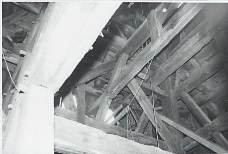
5 Wnętrze dzwonnicy - widok z pd. narożnika wzdłuż przekątnej: w dolnej kondygnacji środkowa belka zawieszona w dwóch parach zastrzałów jak w konstrukcji wieszarowej.
