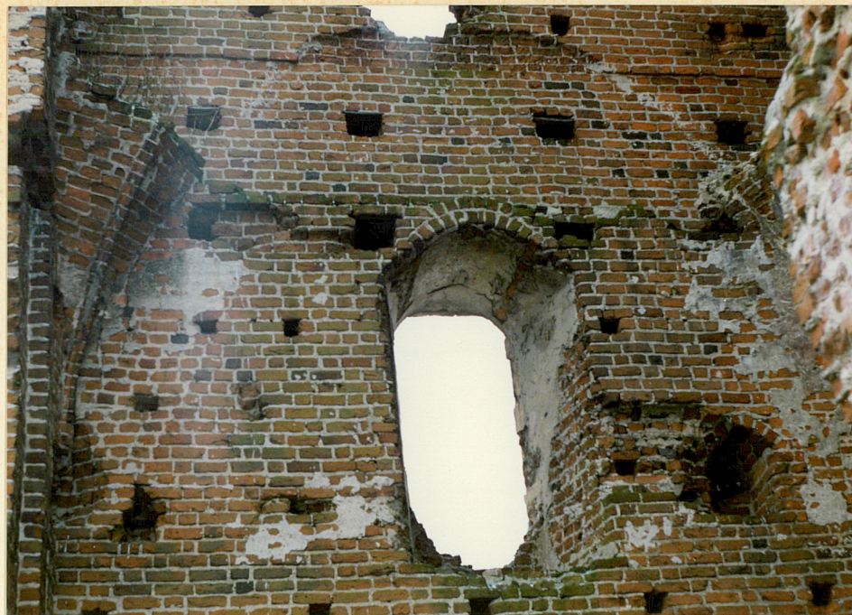
Wieża - pozostałości sklepienia krzyżowo-żebrowego
