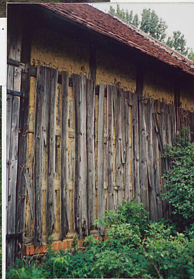
5. Fragment elewacji zachodniej tylnej stodoły północnej (dz.889) - resztki oszalowania - ażurowego.
