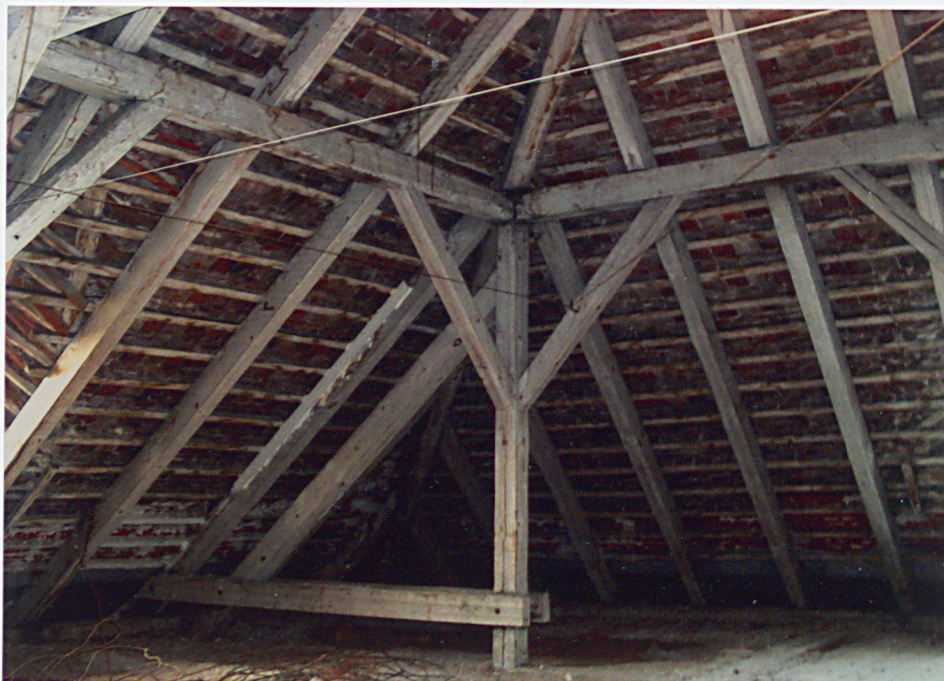
Konstrukcja krokwiowo- płatwiowa z ramą stolcową usztywnioną kleszczami i mieczami
