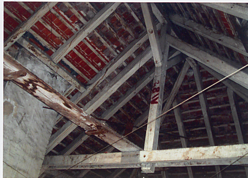
Wiązár z podwieszonym usztywnieniem kleszczowym i zastrzałami
