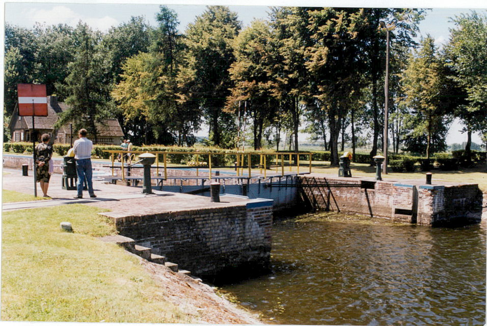
1. Śluza komorowa - głowa od strony górnej wody, neg. 1100/214/6
