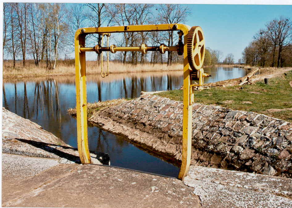
32. Przeławka dla ryb, widok w kierunku wody górnej, widoczne urządzenie do zakładania zamknięć remontowych – szandorów, fot. 6767.
