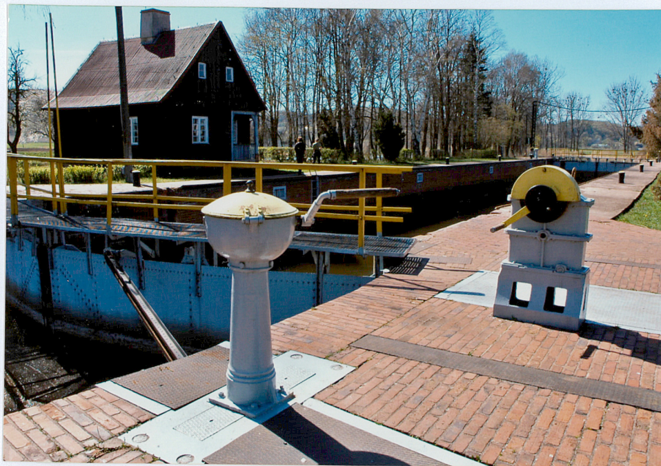
11. Śluza, wrota w głowie górnej, po lewej mechanizm do otwierania i zamykania wrót, po prawej mechanizm do otwierania i zamykania kanałów obiegowych, fot. 6787.
