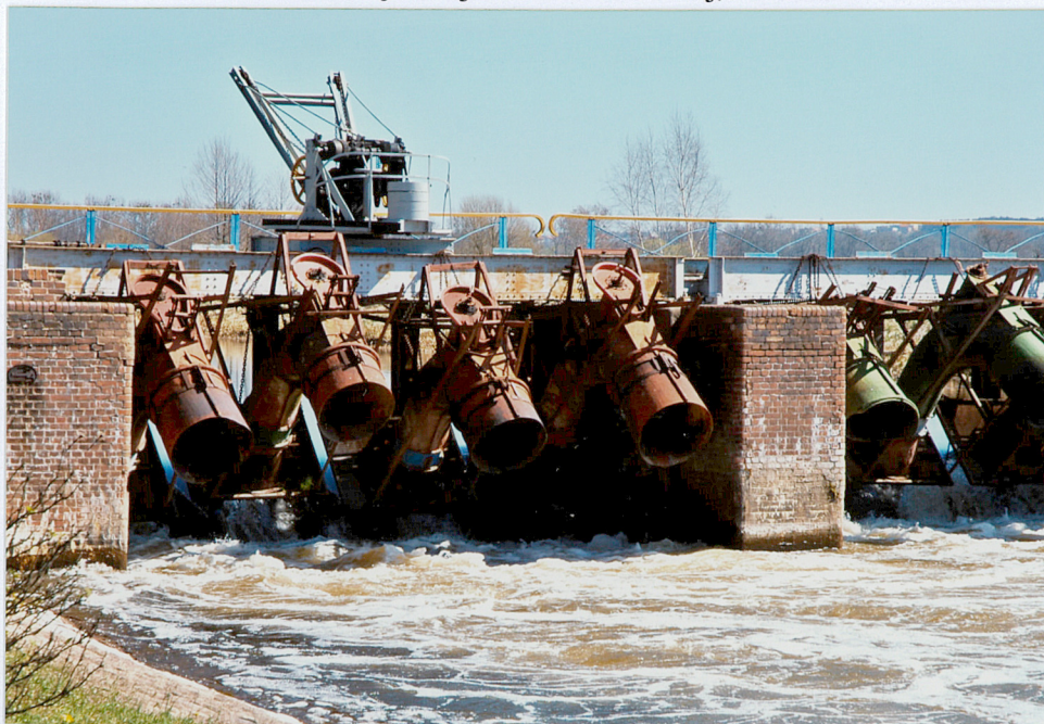
19. Jaz, widok od wody dolnej, widoczne urządzenia prowadzące wodę na turbiny zlikwidowanej małej elektrowni wodnej, fot. 6796.
