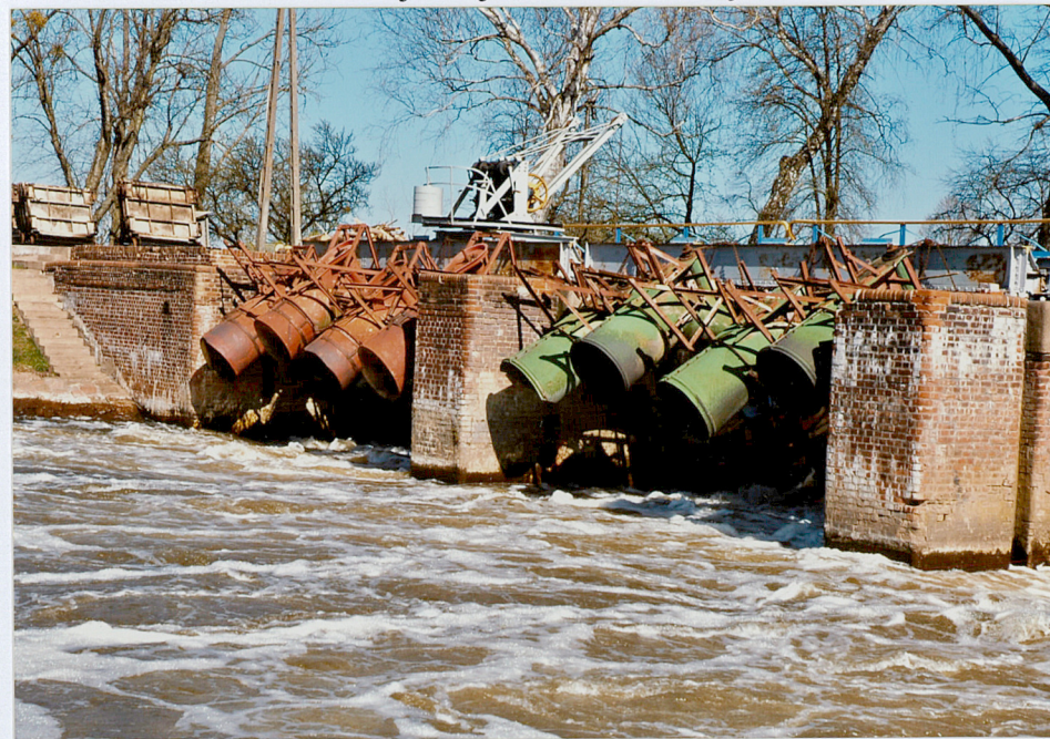
21. Jaz, widok od wody dolnej, widoczne urządzenia prowadzące wodę na turbiny zlikwidowanej małej elektrowni wodnej, fot. 6765.
