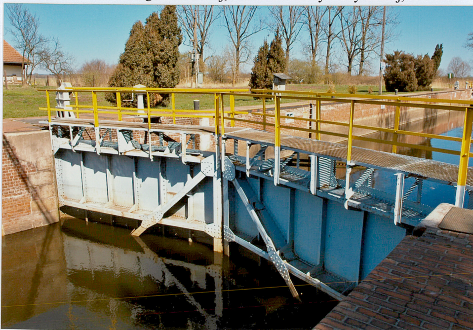
11. Śluza, wrota w głowie górnej, po lewej mechanizm do otwierania i zamykania wrót, po prawej mechanizm do otwierania i zamykania kanałów obiegowych, fot. 6787.
