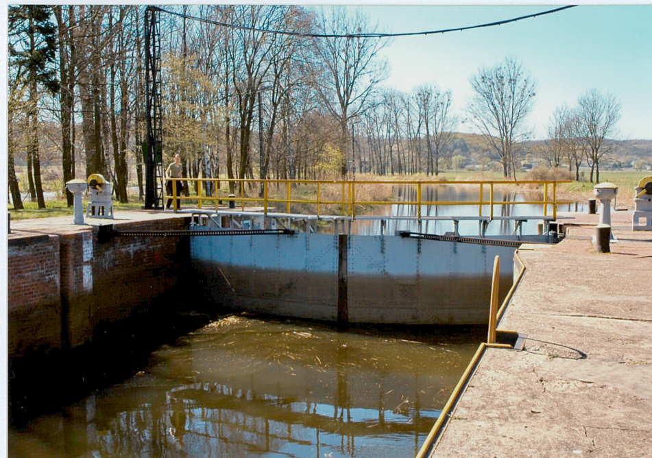
12. Śluza – wrota w głowie dolnej, widok od strony komory śluzy, fot. 6786.
