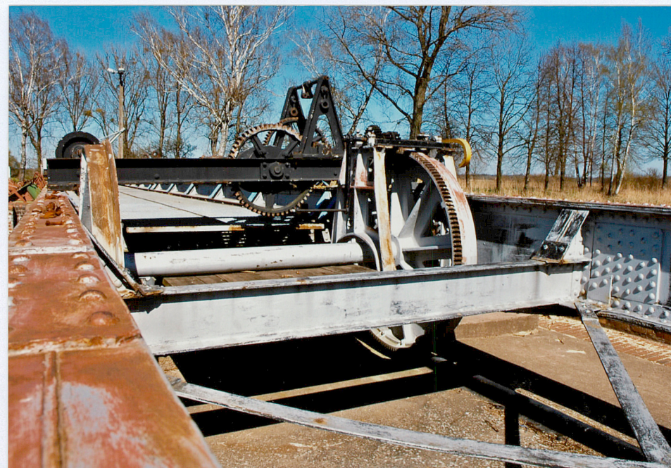
28. Jaz – przęsło ruchome, widoczne urządzenie do przesuwania przęsła, fot. 6772.
