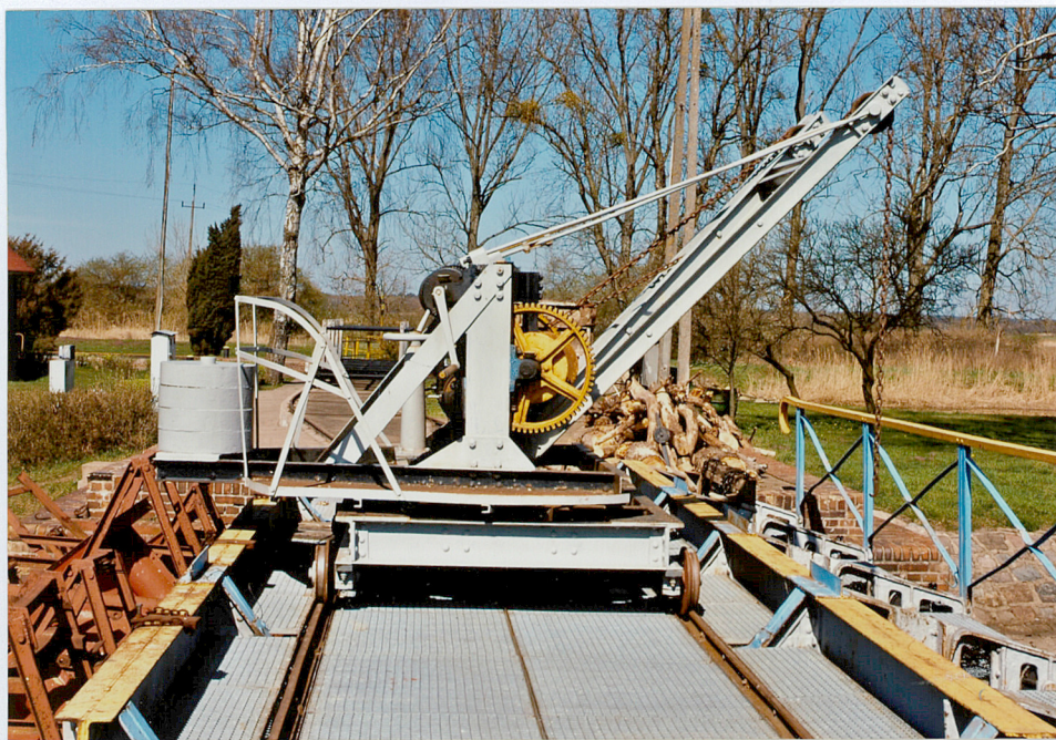
27. Jaz – dźwig do zakładania i podnoszenia zasuw jazu, fot. 6774.
