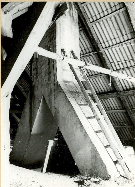
Fot. 2. Komin - cztery przewody kominowe łączą się w jeden.
