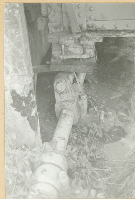
FRAGM. DAWNEGO MECHANIZMU PRZESUWAJĄCEGO PRZĘSKO - WIDOK OD STRONY PN.
