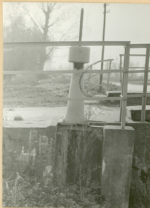
WIDOK OD PN. NA WSCH. CZĘŚĆ MOSTU Z POZOSTAŁOŚCIĄ MECHANIZMU OBRO- TOWEGO
