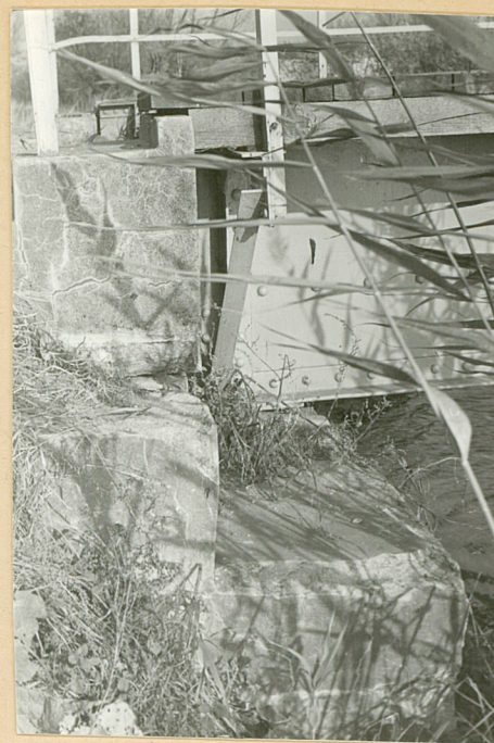
FRAGM. OSADZENIA WSCH. PRZĘSKA OD STRONY PÓŁNOCNEJ
