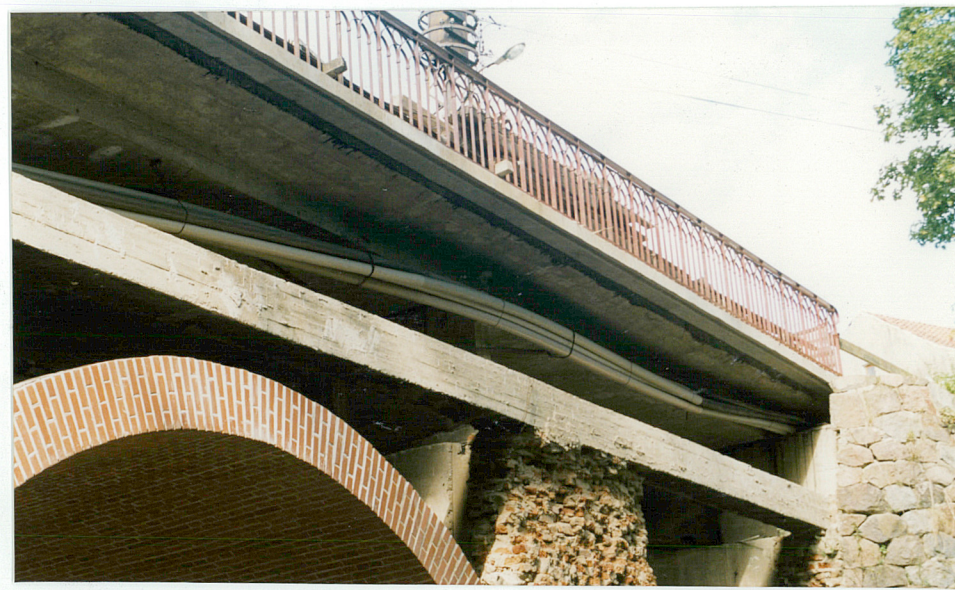
7. Płyta żelbetowa nośna mostu, neg. 1100/534/4.
