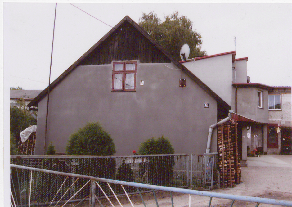
Fot. nr 2. Szczyt od strony ulicy z nałożonym tynkiem cementowym
