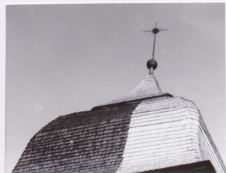
fot.9. Gont na dachu wieży w trakcie wymiany ( po prawej stronie nowy, jaśniejszy)
