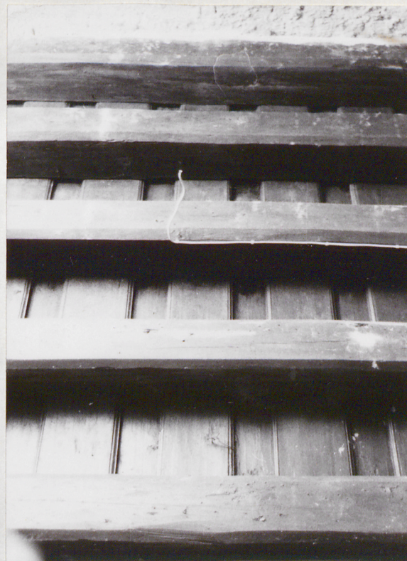
Strop belkowany w sali na parterze
