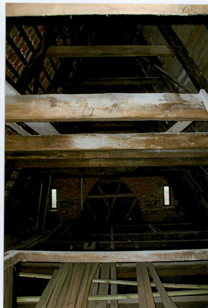
5. WIĘŻBA DACHOWA NAD NAWĄ GŁÓWNĄ
